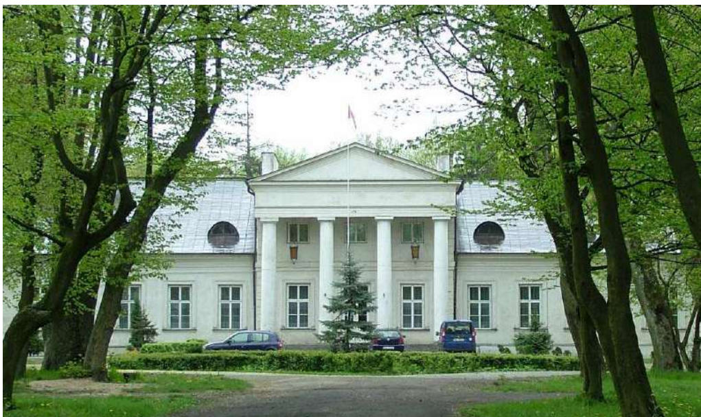
Pałac w Dębinkach
