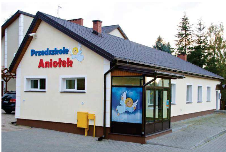
Fotografia 9. Budynek Przedszkola Aniołek w Szpetalu Górnym
