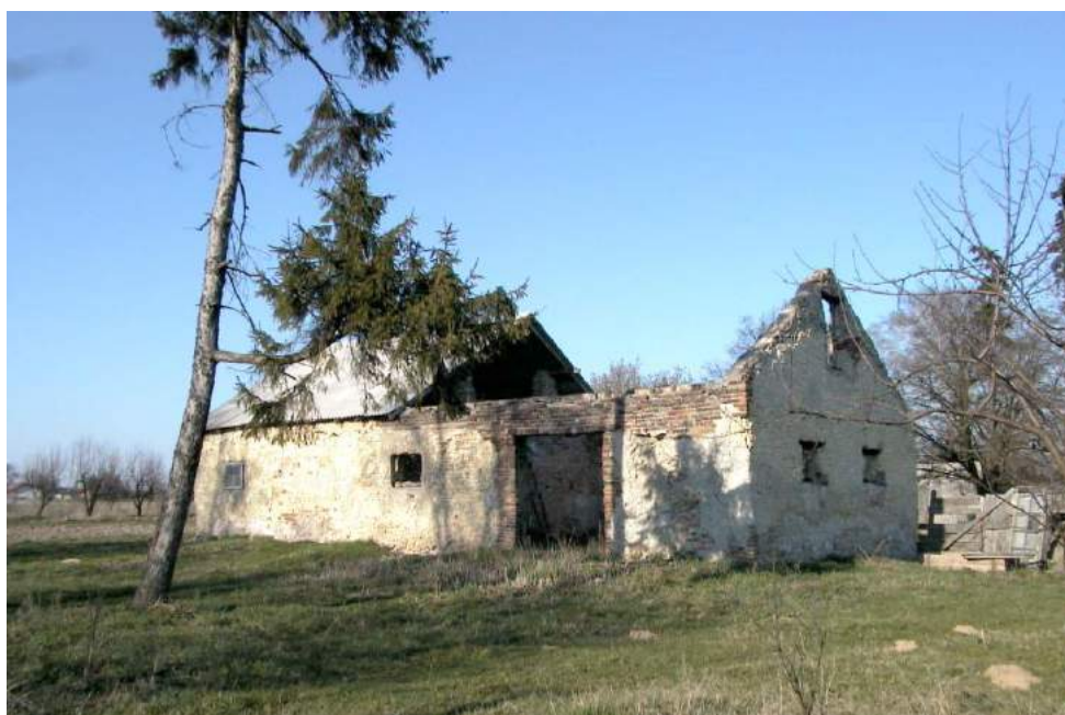
Budynek gospodarczy w Janowicach. Fot. 2004.
