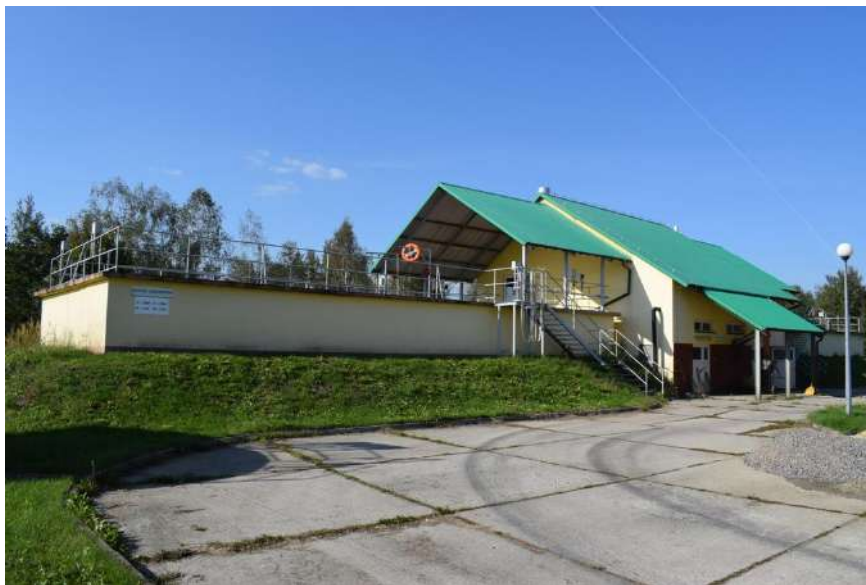
Fot. 40. Oczyszczalnia ścieków w Kępie Zaleszańskim
