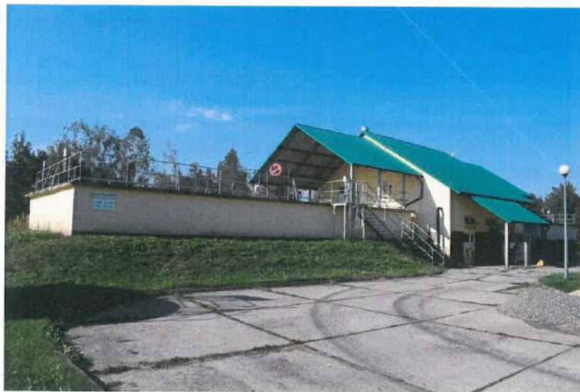
Fot. 40. Oczyszczalnia ścieków w Kępno Zaleszańskim
