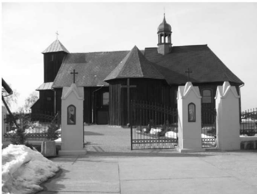
Kościół parafialny p.w. Nawiedzenia NMP, 1717 r., Ostrowo Kościelne
