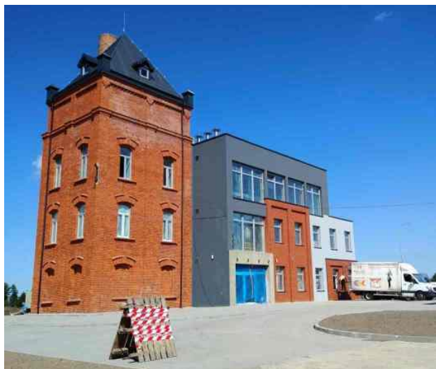
Fot. 16. Obiekt biurowy na terenie Moszczenickich Terenów Inwestycyjnych. Fot. I. Pecyna.
