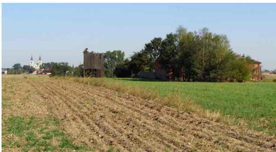
Fot. 11. Ruiny drewnianego wiatraka w Sroczku. Fot. I. Pecyna
