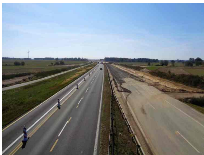
Fot. 19. Prace na autostradzie A1 – odcinek w Sierosławiu. Fot. I. Pecyna.
