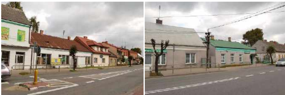
Zdjęcie 3, 4. Zabudowa wzdłuż drogi krajowej nr 50, ulica 1 Maja w miejscowości Kołbiel.
