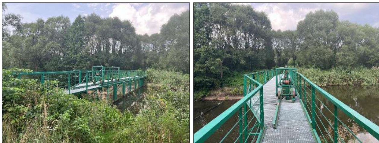
Fot. 3. Zapora wodna na rzece Czernej, poniżej mc. Siedłów
