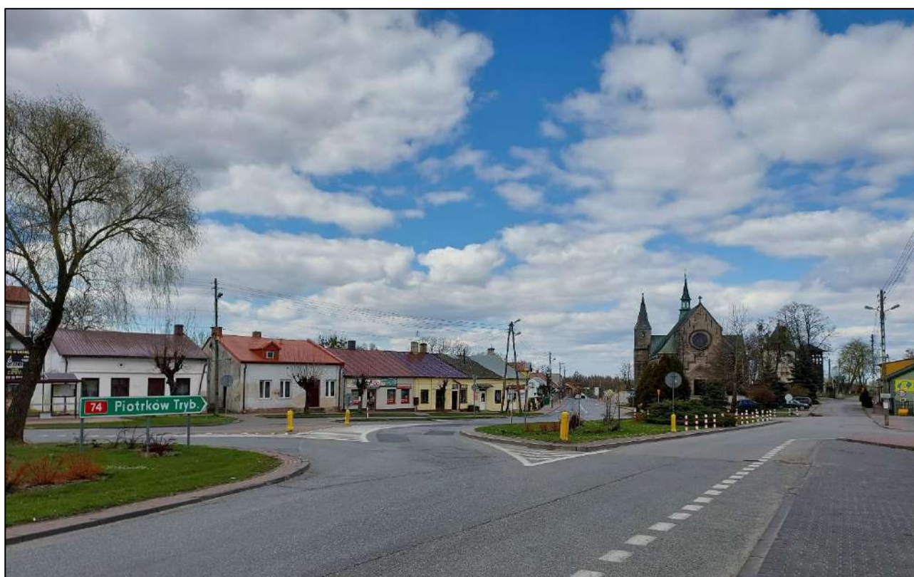
Fot. 9. Widok na fragment centrum Żarnowa w granicach zabytkowego układu przestrzennego – plac zamknięty od północy dominantą przestrzenną – bryłą kościoła rzymsko-katolicki pw. św. Mikołaja
