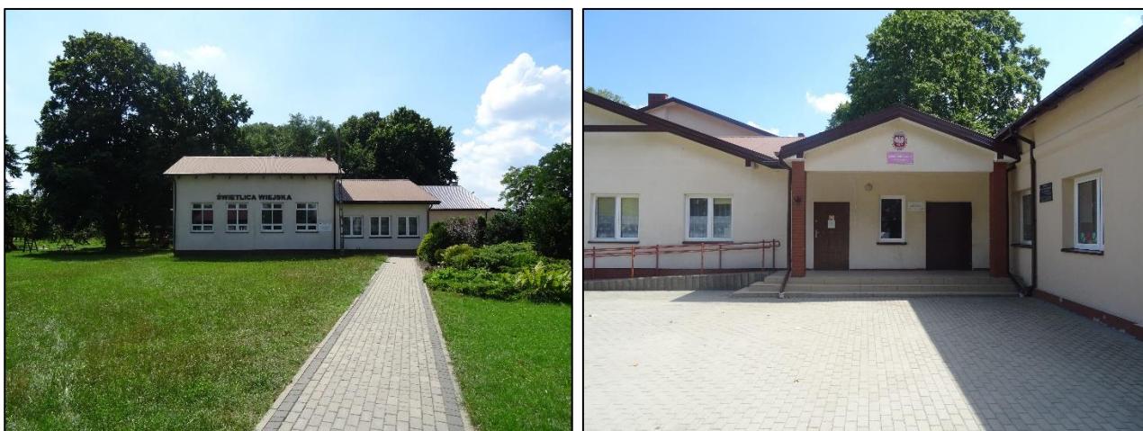
Fot. 13. Szkoła Podstawowa w Sokołowie wraz z świetlicą wiejską i terenami sportu i rekreacji, obiekty zlokalizowane na terenie zabytkowego parku podworskiego
