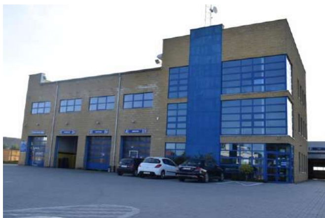
Fot. 7. Budynek stacji kontroli pojazdów w Ćmiłowie
