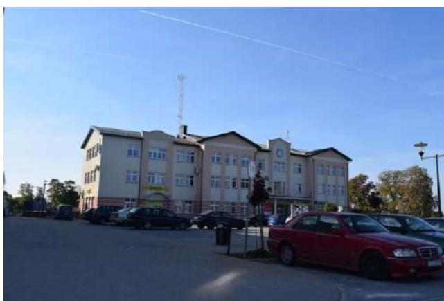
Fot. 5. Budynek Urzędu Gminy Głusk
