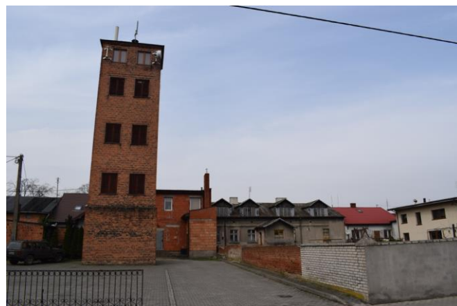
Fot. 6. Wieża remizy strażackiej w Rychwale
