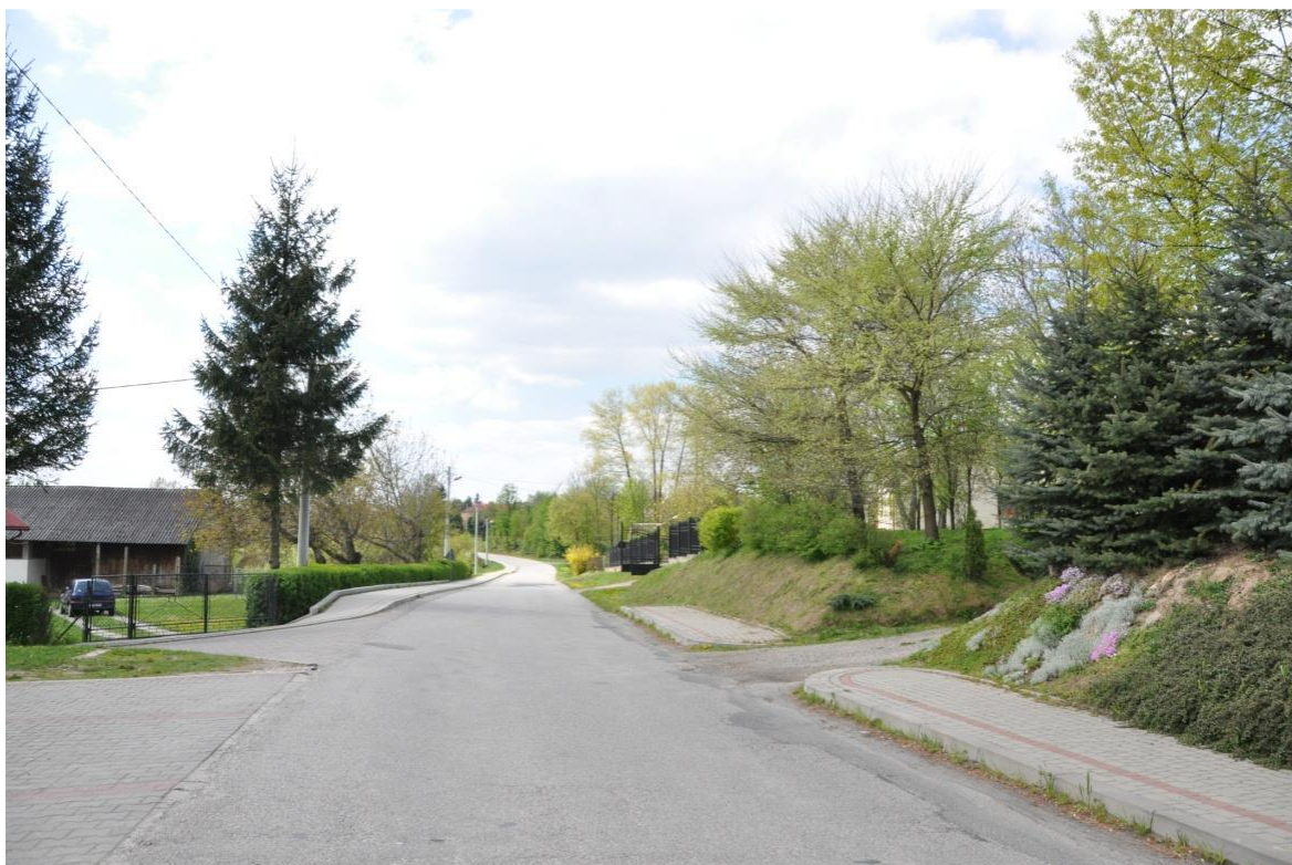
Widok drogi w Rzeplinie
