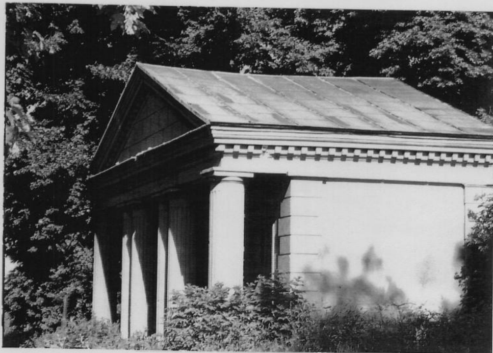
Boratyn, widok kaplicy dworskiej.
