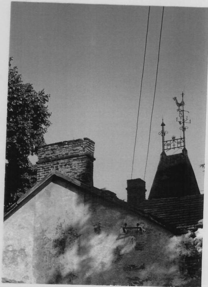
Chłopice, fragmenty dachu i komina domu „Pod kogutem”
