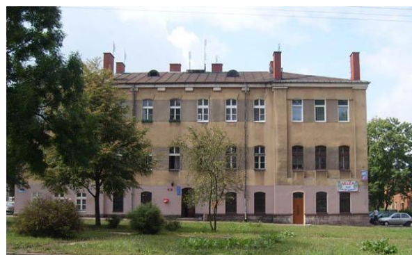
Fot. 12. Budynek koszarowy, Al. Legionów 44a Fot. S. Kotecka.
