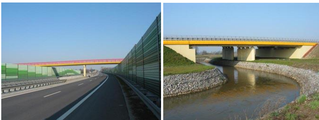
Fot. 19. Droga S17 w rejonie Garwolina. Kładka dla pieszych i most przez rzekę Wilgę Źródło: www.gddkia.gov.pl
