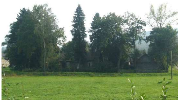
Fot. 79 Widok na drewnianą zagrodę w Smarżowej
