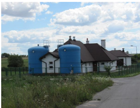
Fot. 40. Oczyszczalnia ścieków w Pawłowie
