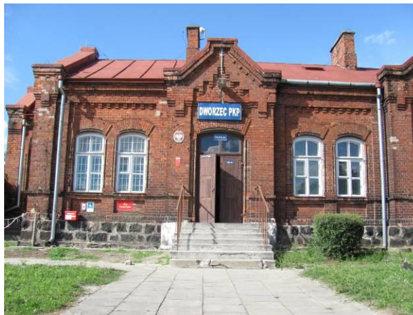
Fot. 10. Dworzec PKP Kanie
