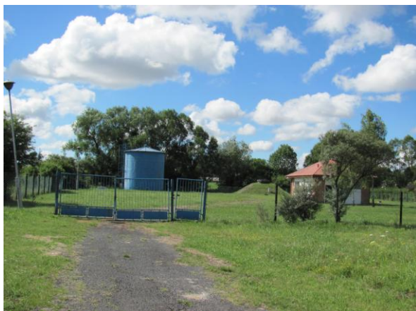
Fot. 38. Ujęcie wody w Pawłowie
