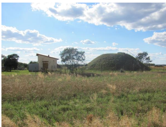
Fot. 39. Ujęcie wody w Wólce Kańskiej Kolonii
