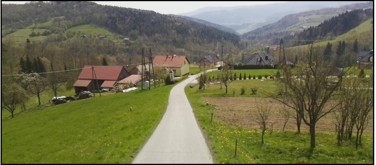
Fotografia 5. Zdjęcie drogi gminnej w miejscowości Rozdziele
