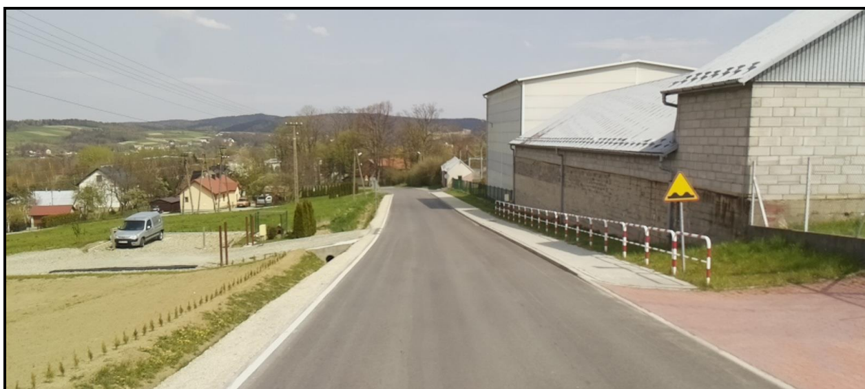
Fotografia 4. Zdjęcie drogi powiatowej w miejscowości Łąka Górna
