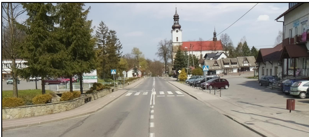
Fotografia 3. Zdjęcie drogi wojewódzkiej w miejscowości Żegocina
