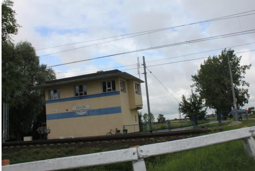
Fotografia 12. Stacja kolejowa Książki.
