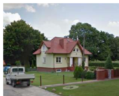
zabudowa podmiejska w Nowej Wsi Małej
