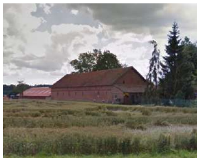
budynek inwentarski w Nowej Wsi Małej
