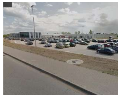
zabudowa produkcyjna i magazynowa przy ulicy Olsztyńskiej
