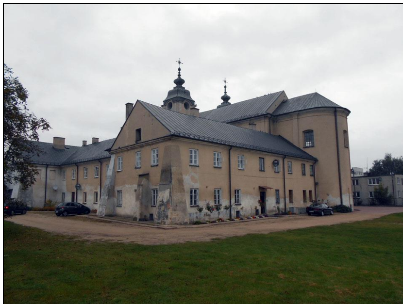
Fot. 1. Klasztor w zespole klasztornym franciszkanów, wpisany do rejestru zabytków rej. nr 117/A/58z dnia 20.05.1958 r., oraz 178/A z dn. 15.10.1982 r. Fot. G. Ferliński.
