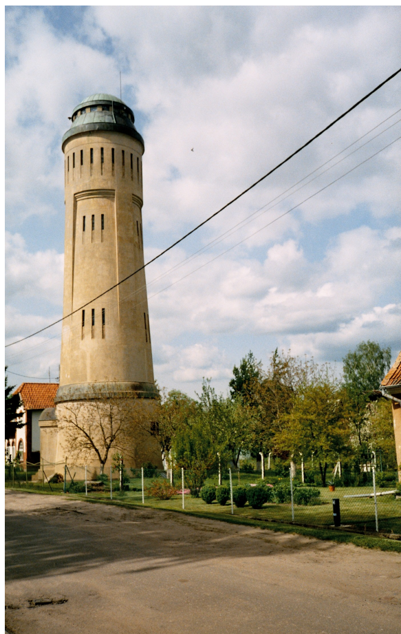
Zdjęcie III/6 Wieża ciśnień w Sępopolu
